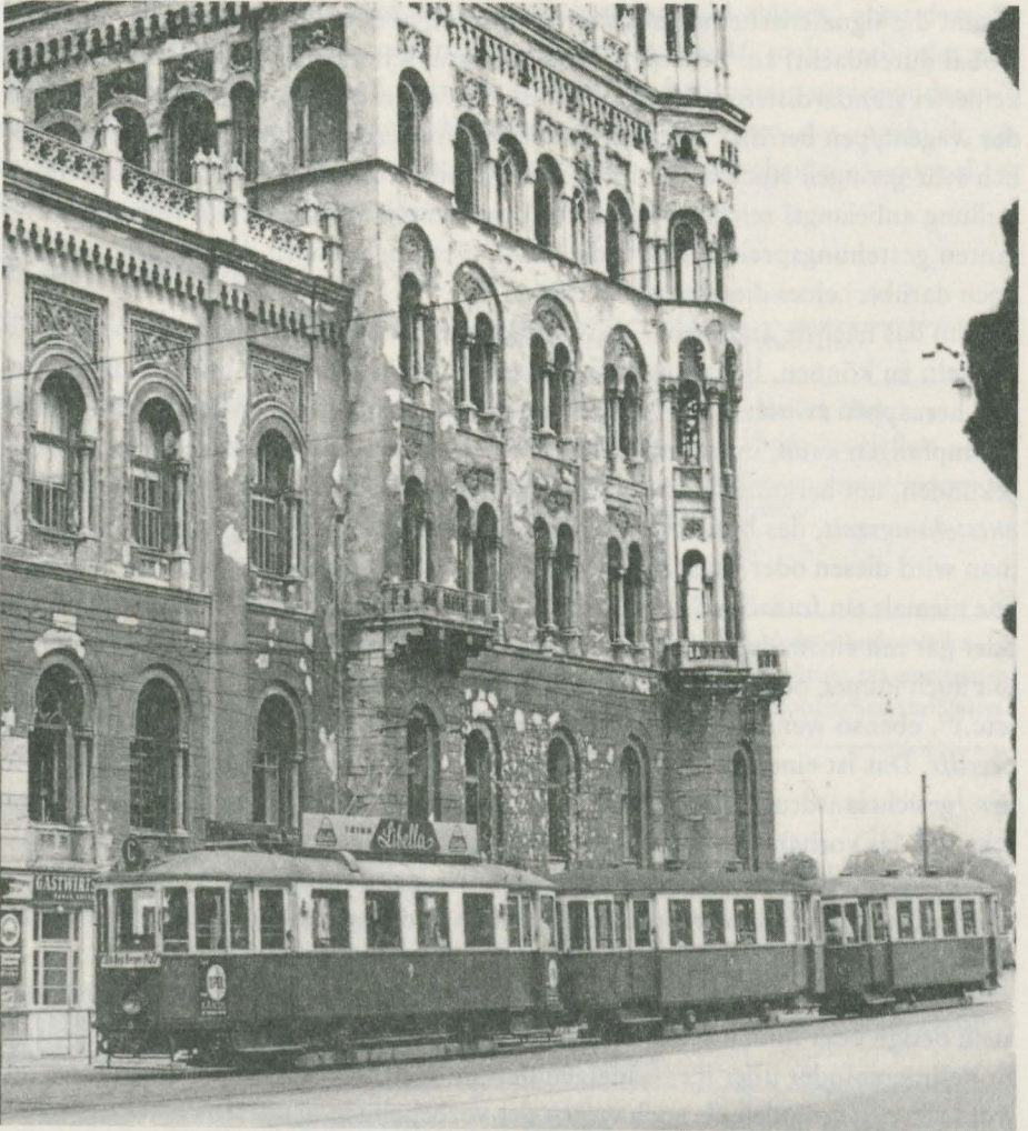
Abb. 11: Das vorletzte Beispiel für eine eigenständige ästhetische Lösung bei der Wiener tramway. »M«-dreiwagenzug vor dem schliesslich doch noch mutwillig zerstörten Nordbahnhof. Der motorwagen weist einen »lyrabügel« auf, hat aber schon schienenbremsen (adhäsionsunabhängig, mit einem halben jahrhundert verspätung auch in Wien »in mode« gekommen). Die zielangabe ist ungeschickt, besser wäre die angabe des bezirks und des stadtviertels. Am absurdesten war die bezeichnung der nördlichen endstation (»endstelle«) der linie 8: »Glatzgasse« – eine kaum 100 m lange, völlig unbekannte gasse am Döblinger Gürtel. (Die Type M der Wiener Verkehrsbetriebe. Wien, Pospischil 1978.)
