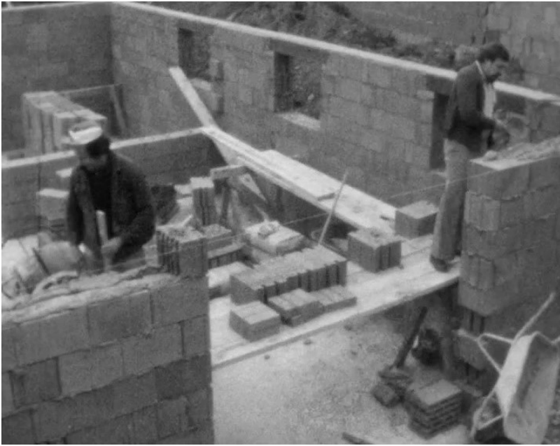
Abbildungen 4a und 4b: Beim Kellermauern und beim Aufstellen, nachdem die Fertigteile mit dem Kran herantransportiert wurden
