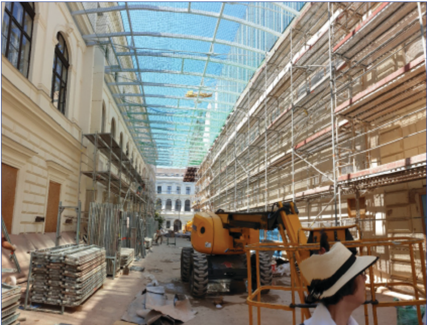
Abb. 3: Ansicht von der Errichtung des neuen Foyers zwischen Uni-Hauptgebäude links und historischem Bibliothekstrakt rechts vom 28. Juni 2019 (Foto: Universitätsbibliothek, Robert Ramschak)
