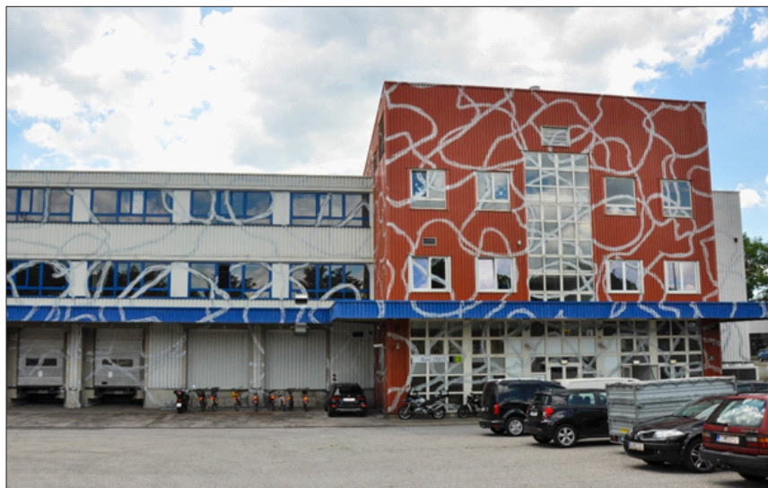
Abb. 9: Ehemaliges Zentrallager einer Schuhfirma, jetzt UB-Standort; die Magazine befinden sich hinter den Laderampen, die Büros für die Verwaltung im 2. OG über den Laderampen; im 1. OG sind Abteilungen des Steiermärkischen Landesmuseums Joanneum untergebracht.
