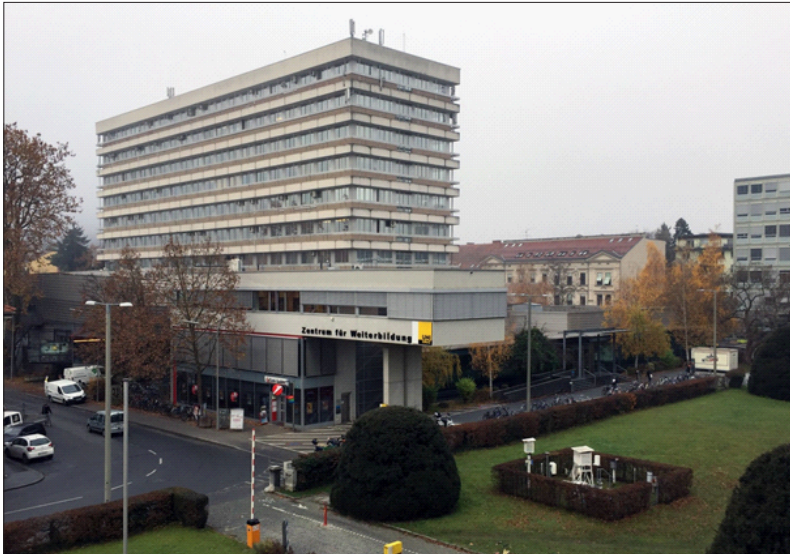
Abb. 3: Gebäudekomplex, der aktuell die vorklinischen Institute der Medizinischen Universität Graz beherbergt. In Zukunft sollen darin die philologischen Institute samt einer großen Bibliothek für Sprachen und Literaturen untergebracht werden.
