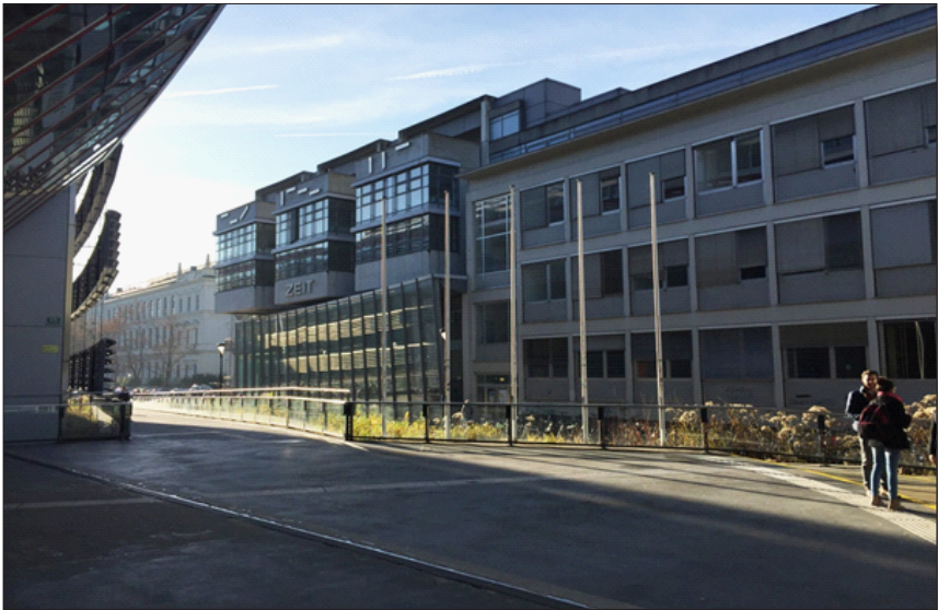
Abb. 5: Links der 1996 eröffnete Bauteil I von Günther Domenig und Hermann Eisenköck, rechts der aus dem Jahr 1970 stammende Erweiterungsbau
