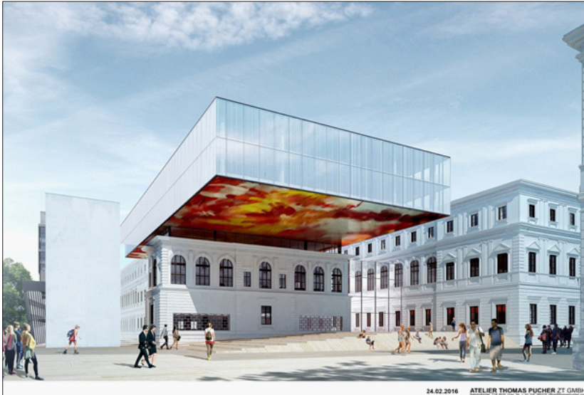
Abb. 6: Das Siegerprojekt aus dem Atelier Thomas Pucher mit der freigelegten historischen Nordfassade und dem zweigeschossigen Glasbalken
