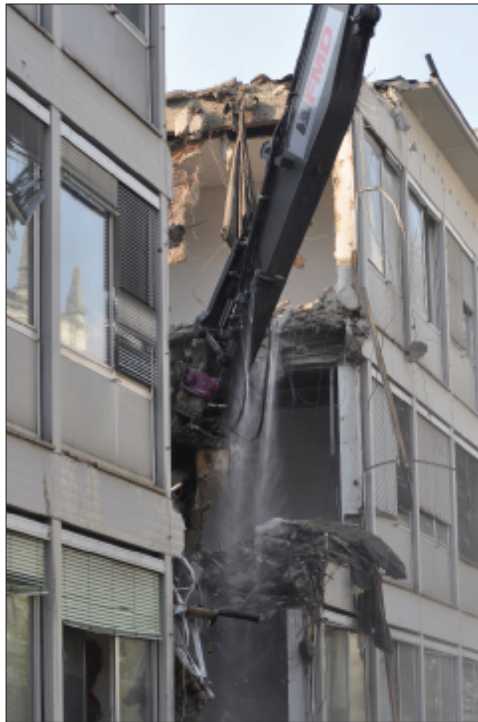
Abb. 2: Die ersten Mauern fallen (Foto: Robert Ramschak)
