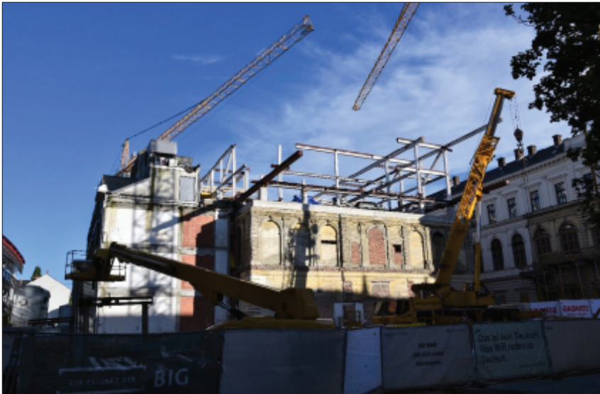
Abb. 5: Errichtung des Stahlskeletts für die Auskragung (Foto: R. Ramschak)
